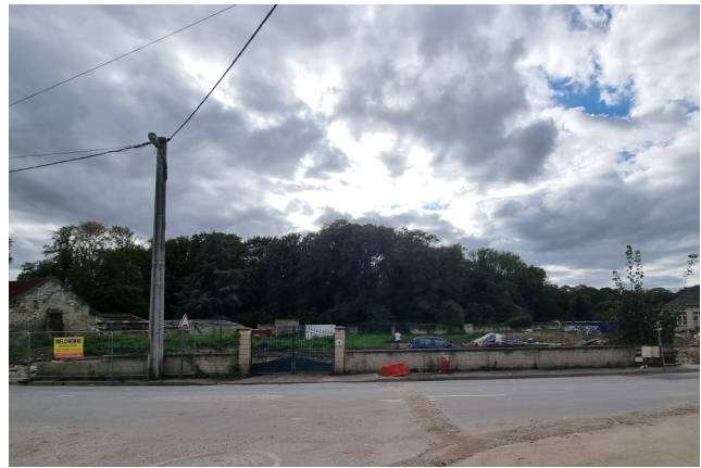
Démolition des derniers bâtiments
